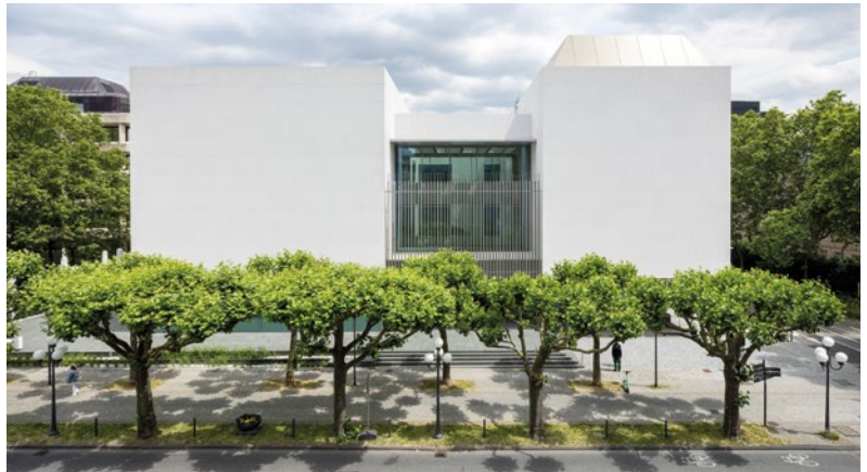
Das minimalistische Gebäude besticht durch die unsichtbare Integration technischer Komponenten – entscheidende Voraussetzung dafür, das klare Erscheinungsbild des „Zuckerwürfels“ zu bewahren.
